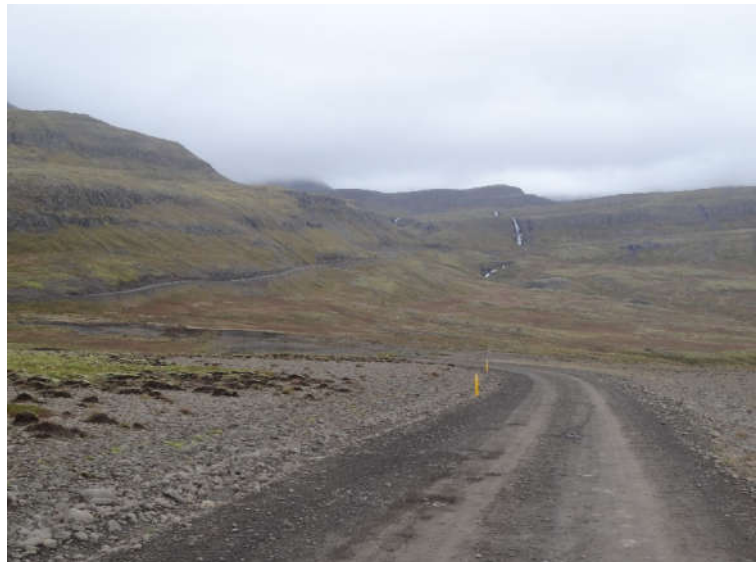
Mynd 3.1: Horft eftir núverandi vegi í átt að Steinhlíð sem er fyrir miðju. Bæjará sést hægra megin á mynd. Mynd HBJ.
